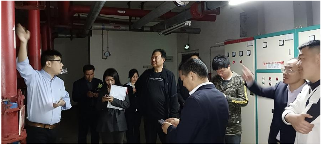
专家组一行检查消防水泵房设施设备运行安全
